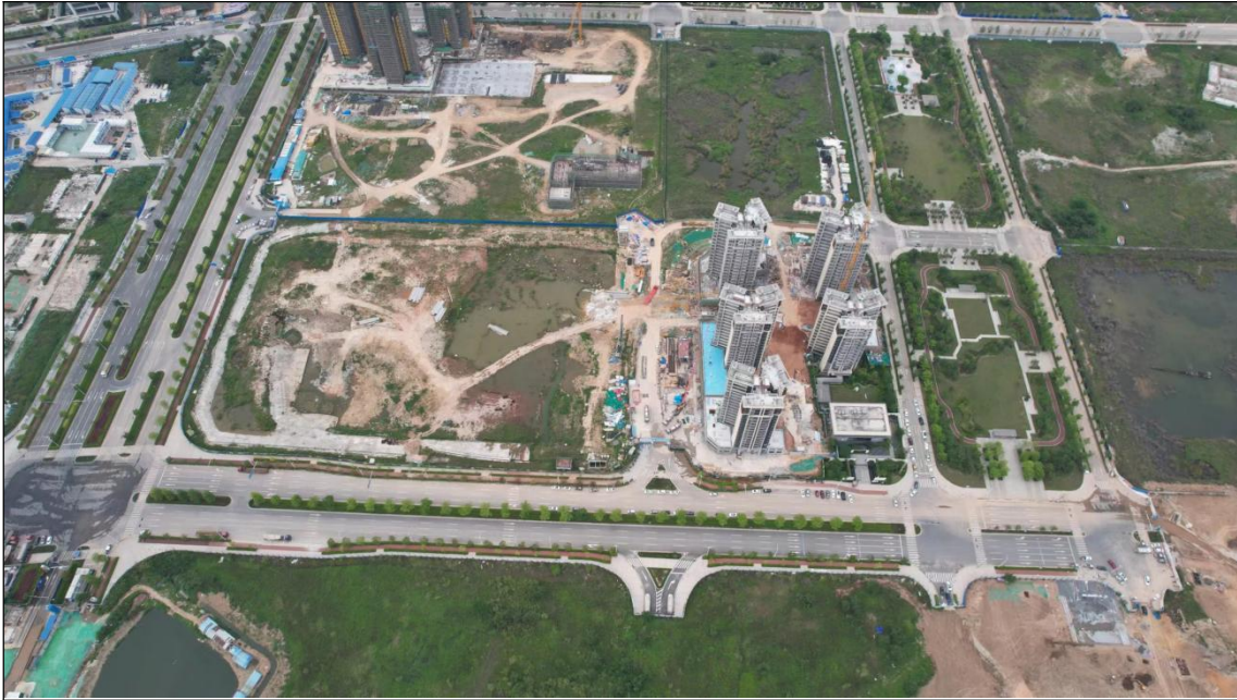
北侧（新港路及建设工地）
