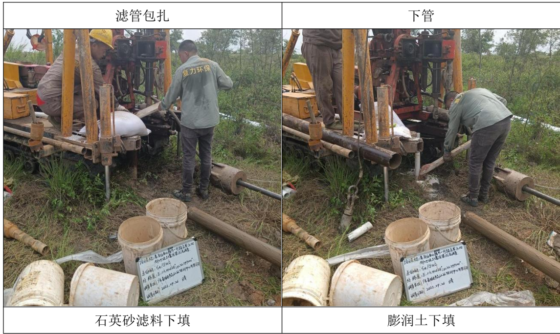
图 4.2-4 地下水监测井成井过程
