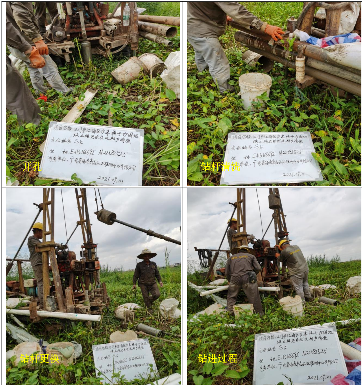
图 4.2-1 土壤钻探过程现场照片
