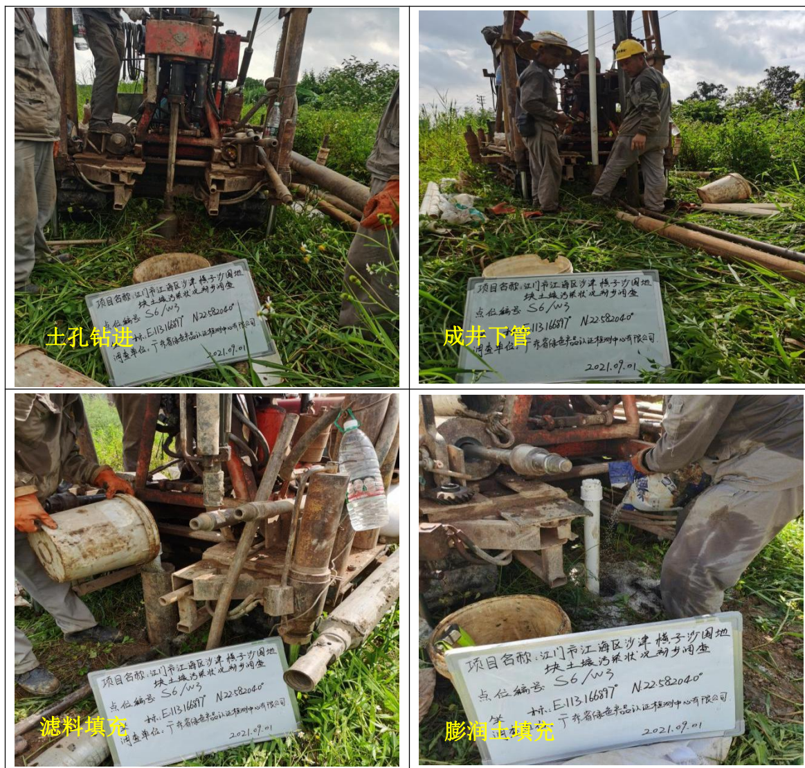
图 4.2-3 地下水监测井成井过程
